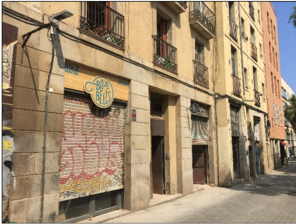
FOTO 01. Finca del carrer dels Metges, 16
