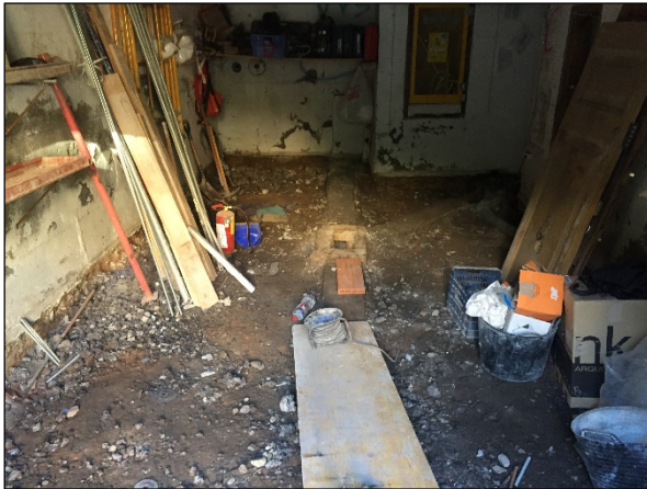
FOTO 03. Estat inicial després de retirar el paviment. Àmbit 1
