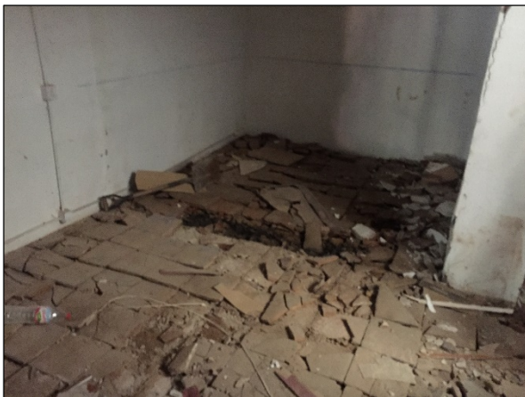
FOTO 05. Retirada del paviment UE 1 de l'àmbit 2a
