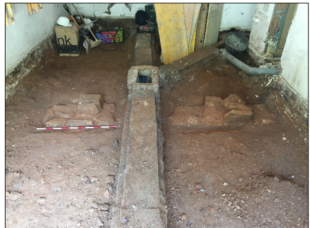
FOTO 12. Estat final del rebaix a l'àmbit 1 amb el mur UE 7
