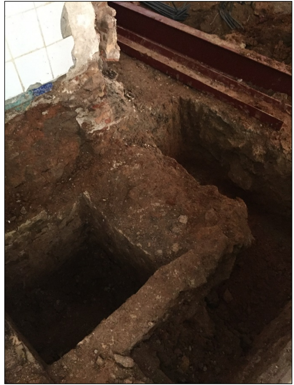
FOTO 26. Fossat de l'ascensor
