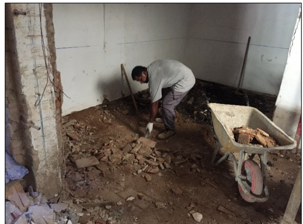
FOTO 06. Retirada del paviment UE 1 de l'àmbit 2a
