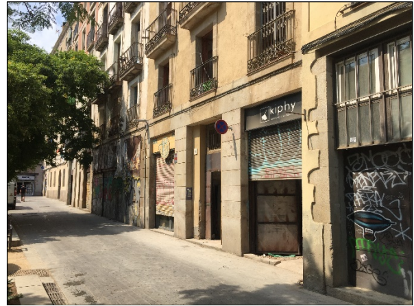
FOTO 02. Finca del carrer dels Metges, 16
