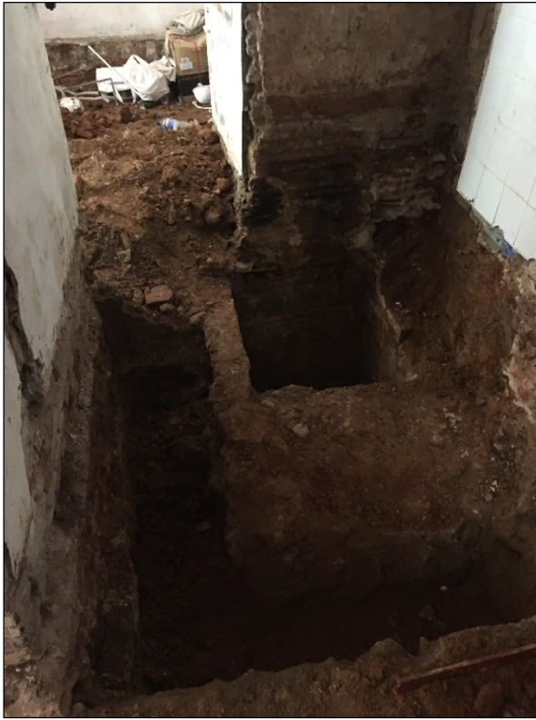
FOTO 25. Fossat de l'ascensor
