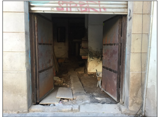
FOTO 04. Estat inicial després de retirar el paviment. Àmbit 2
